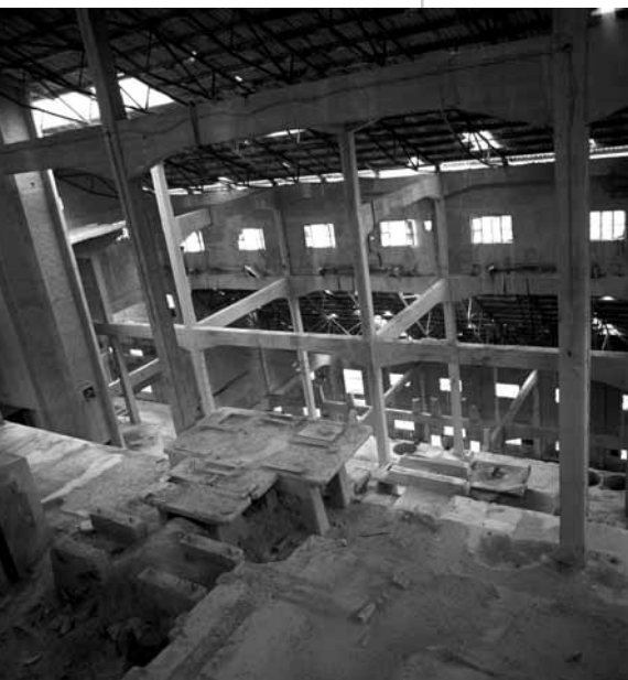
Vue actuelle de l'intérieur de l'usine d'amiante
