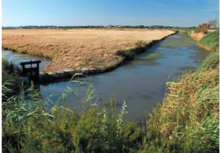
Vers le fort de la Pointe, une vanne entre des canaux.
