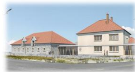
L'entrée et l'ensemble des bâtiments de la Maison du site
